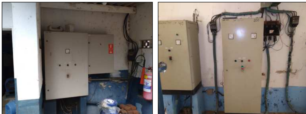
Figura 5 – Painéis elétricos dos conjuntos motor-bomba de captação de água bruta
